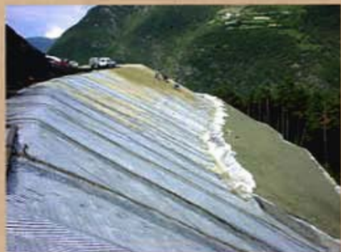
maig 2001 - instal·lació de la capa de cobriment
